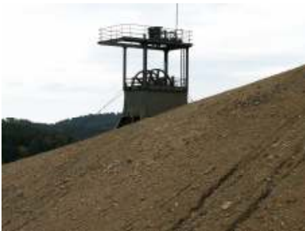
Laven går rakt ner i byggnadens tak.
